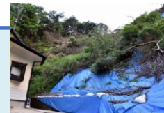
豪雨の度に 土砂崩れが多発
