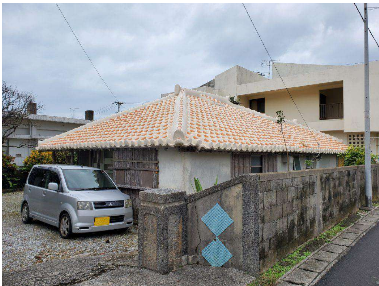
赤瓦屋根はしっくい補修されている
