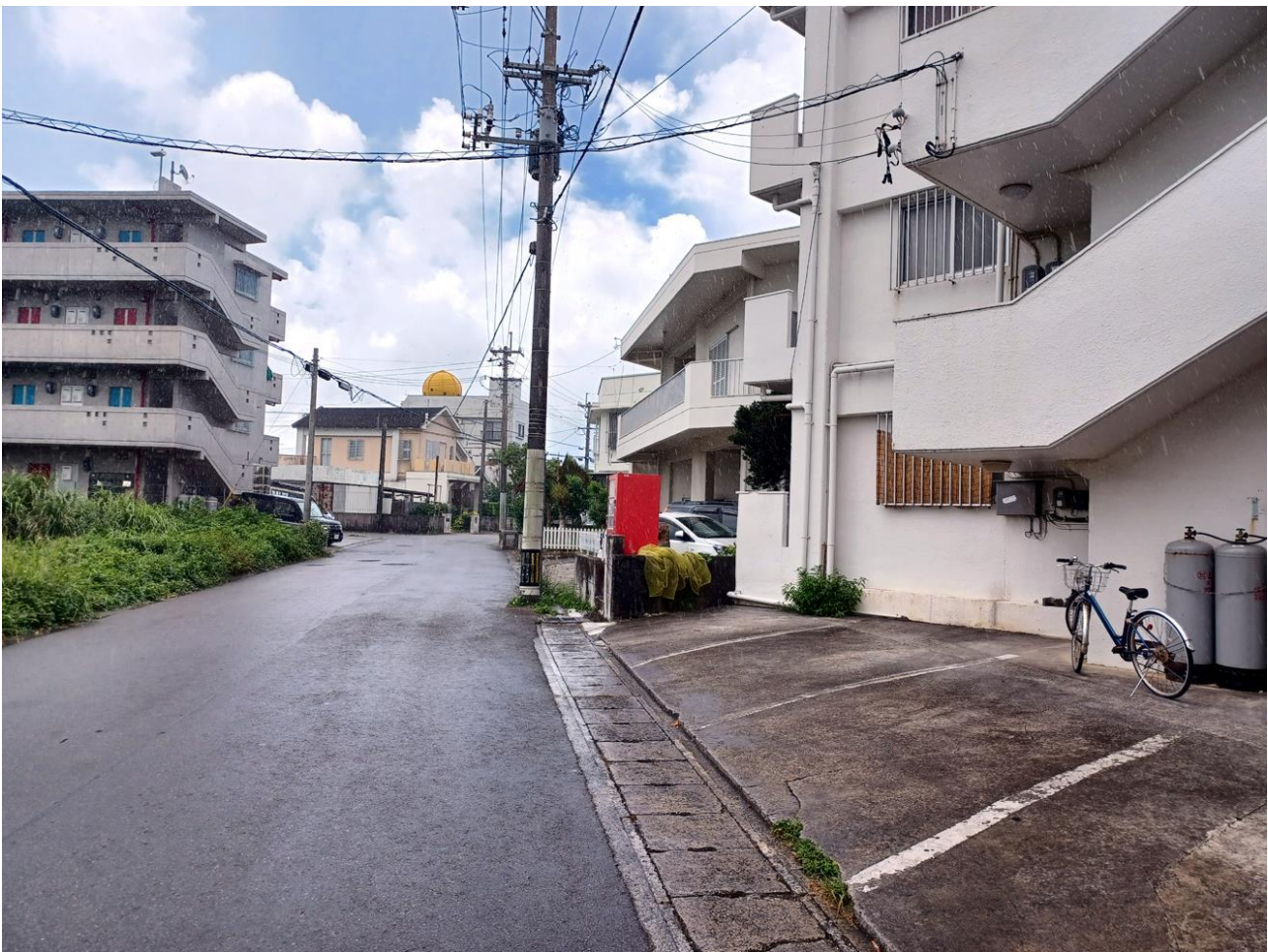
接面道路 石垣市道／幅員 6～7 m
