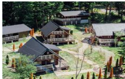
分譲別荘・多棟型コンドミニウム
