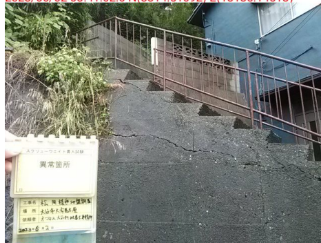
隣家階段部亀裂状況
